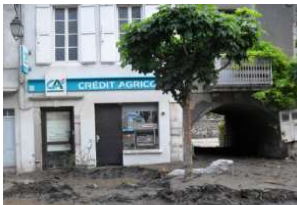
A l'intérieur de l'agence du Crédit Agricole, l'eau est montée jusqu'au plafond.
